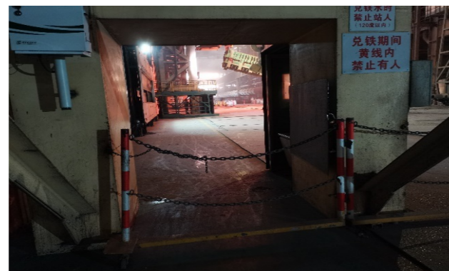
安全防护设施
